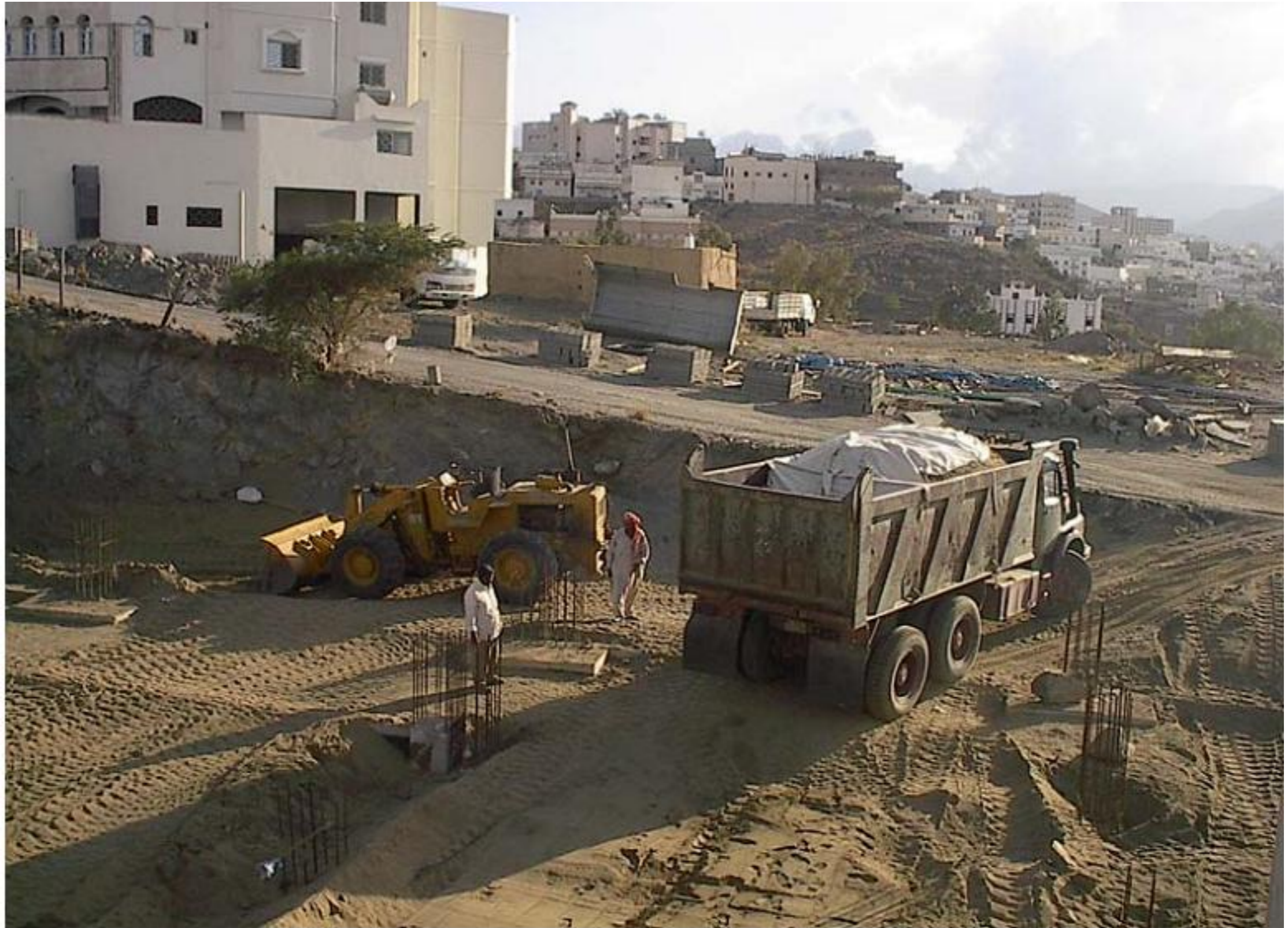
شكل رقم (٨) أعمال الحفر والردم في أحد المشروعات
